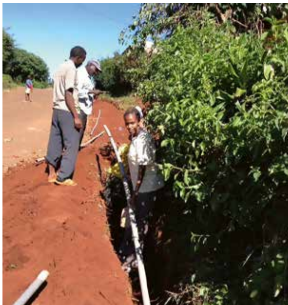
Grävning av diken och rörläggning för vatten i Kenya. Arbetet leds av kvinnor. Foto: Jacqueline Njambi Kamau [CC BY-SA 4.0].
